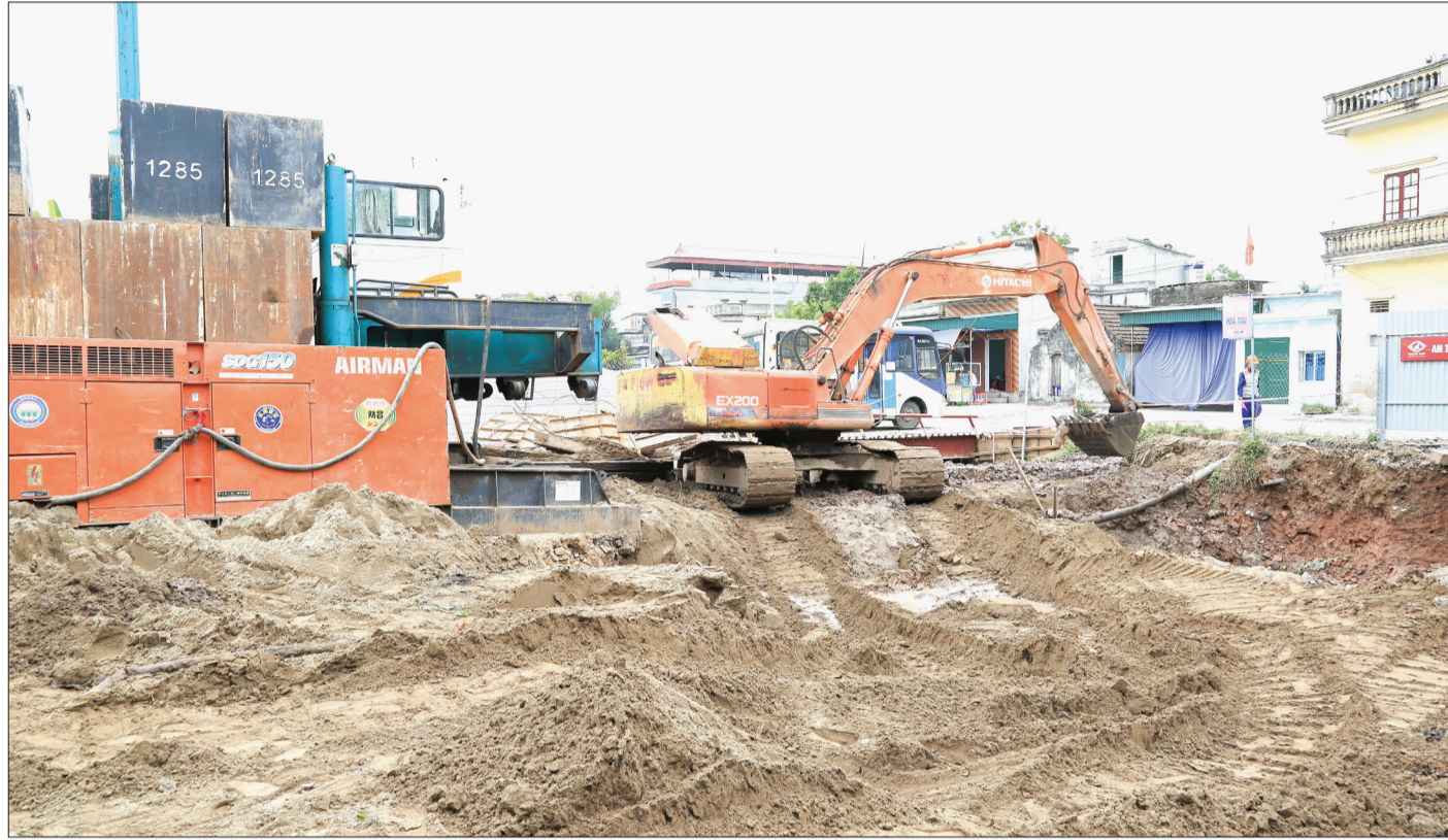
Cầu Giai thuộc địa phận xã Minh Lăng (Vũ Thư) trên tuyến đường từ thành phố Thái Bình qua cầu Tịnh Xuyên đến huyện Hưng Hà đang được thi công.
