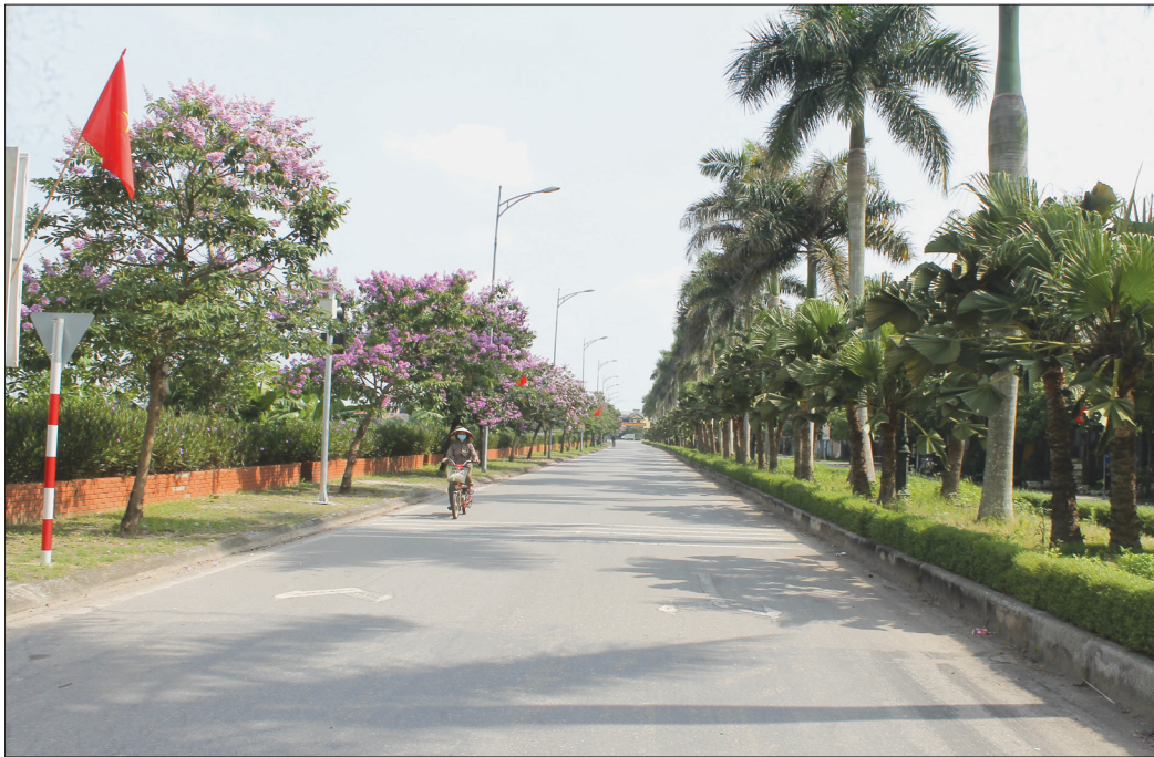
Hệ thống điện chiếu sáng đường giao thông lắp đặt tại xã Tân Hòa (Vũ Thư).
