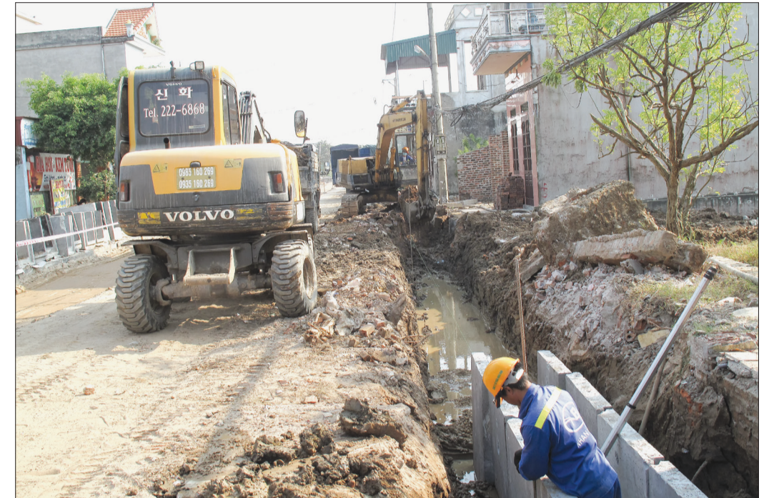
Đơn vị thi công tuyến đường ĐH 95B cơ bản hoàn thành việc thi công hệ thống thoát nước.
