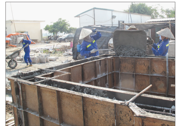
Đơn vị thi công đúc cấu kiện bê tông hệ thống thoát nước.
