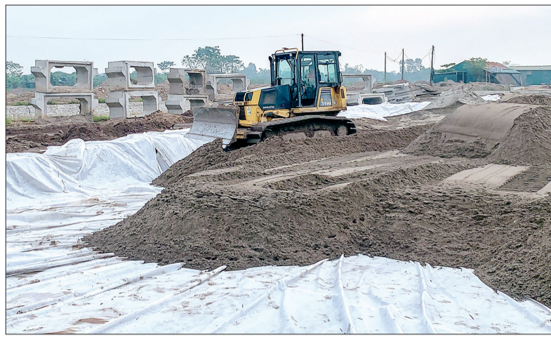
Thi công nền đường tại địa phận xã Song An (Vũ Thư).
