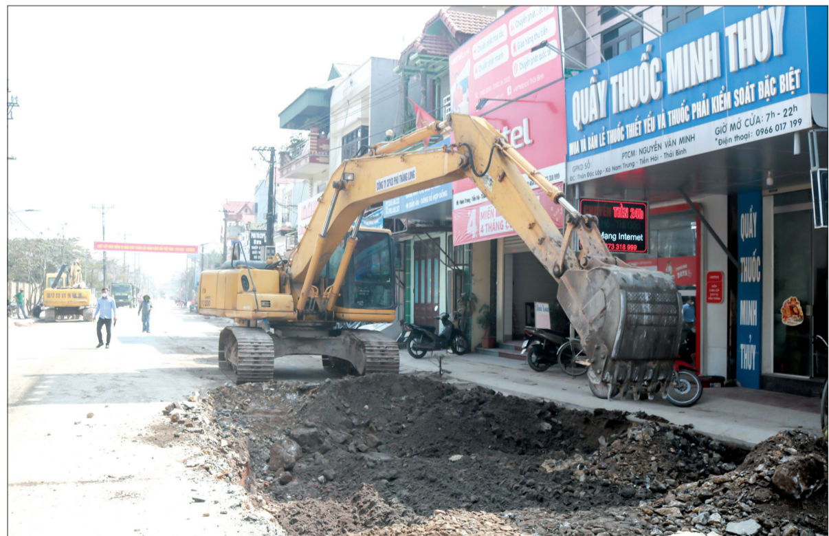
Đơn vị thi công phấn đấu hoàn thành tuyến đường 221B trong tháng 6/2022.
