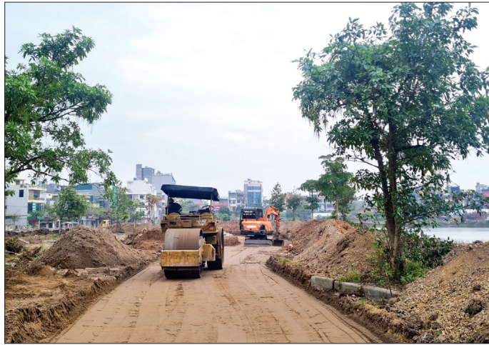
Các hạng mục công trình công viên Kỳ Bá đang được khẩn trương thi công.
