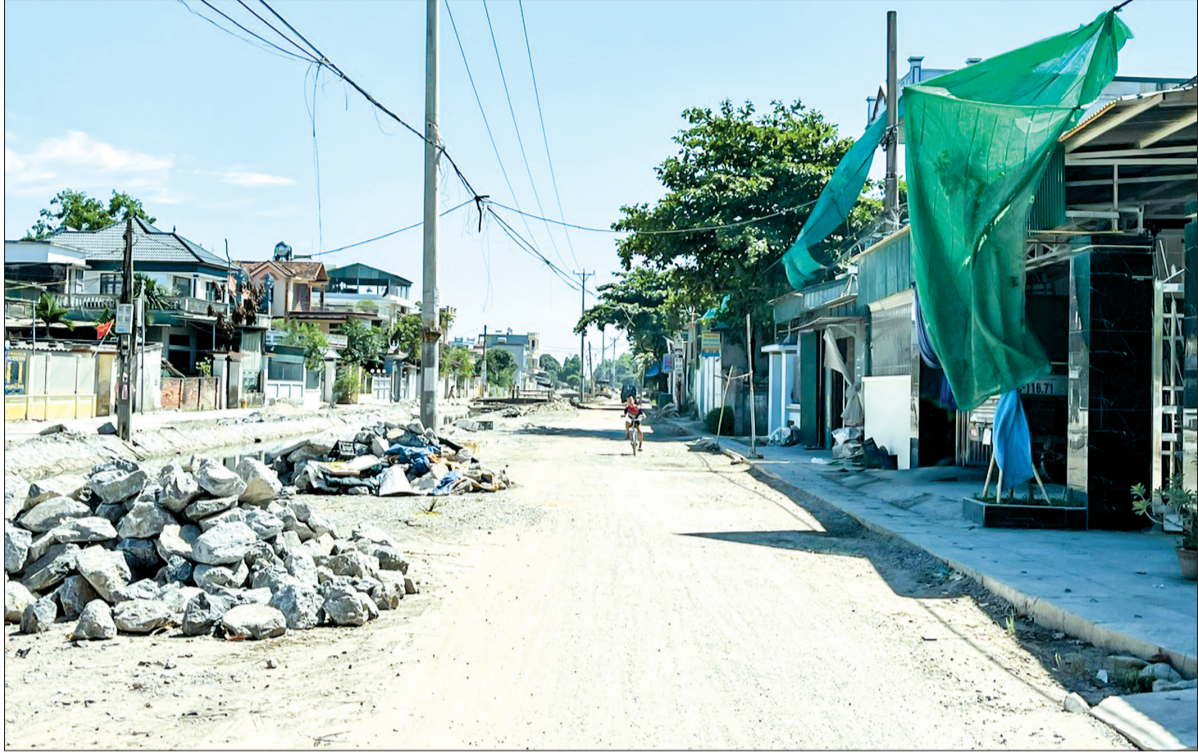
Nhờ làm tốt công tác tuyên truyền, vận động, nhiều hộ dân xã Tân Phong (Vũ Thư) đã chủ động tháo dỡ tường bao, mái che, mái vẩy, thu dọn cây cối để bàn giao mặt bằng thi công tuyến đường cứu hộ, cứu nạn qua địa bàn xã.
