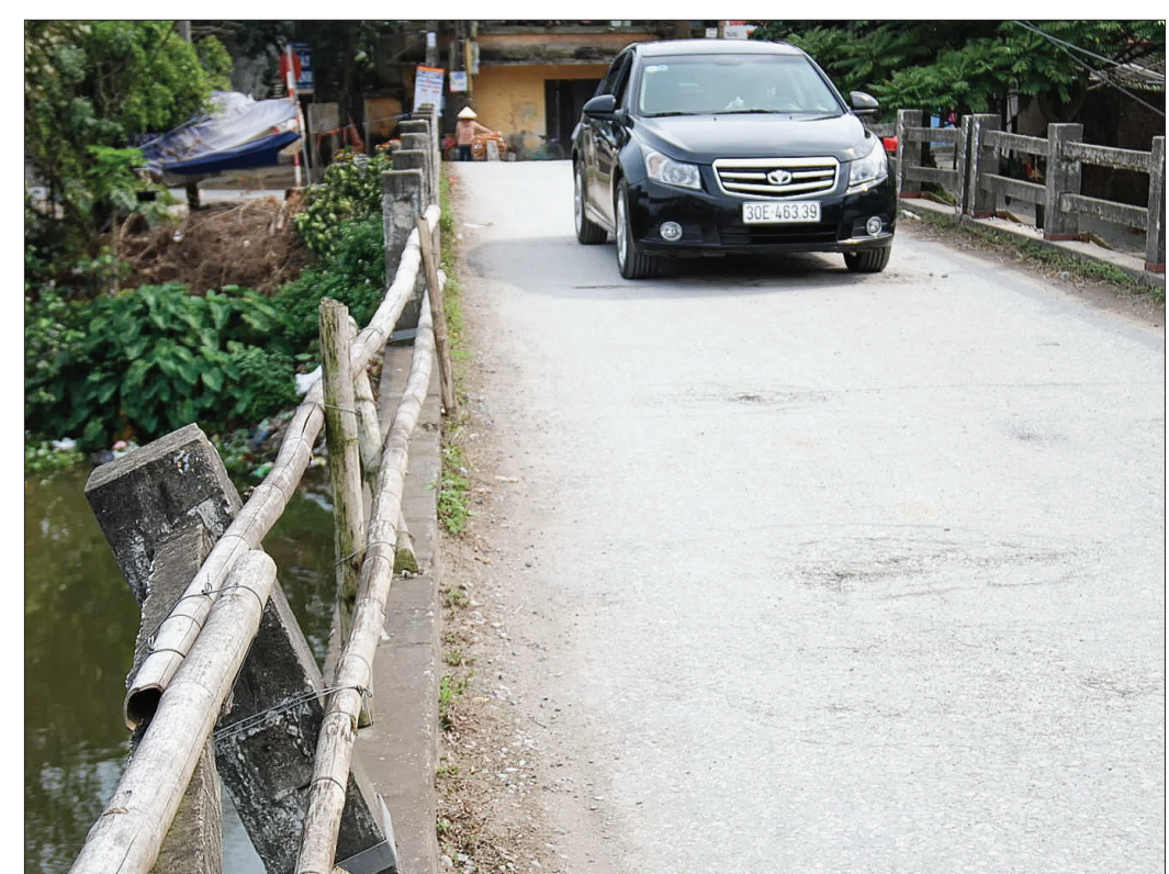
Thành cầu Vũ Trung được chèn tạm bằng tre, luồng.
