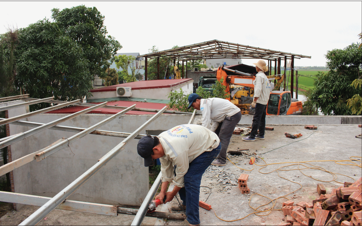
Công ty Tiến Việt Nhật huy động nhân lực, phương tiện tháo dỡ công trình vi phạm.
