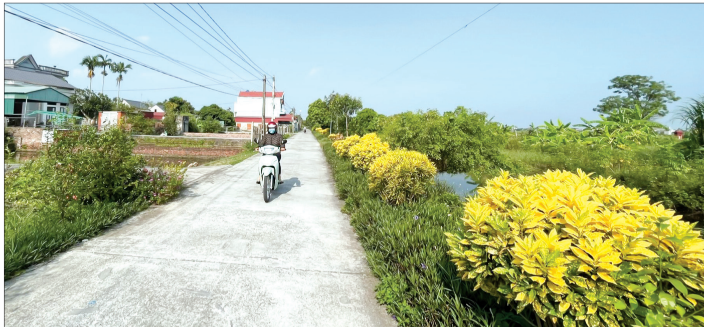
Đường giao thông thôn Hạ Liệt, xã Thái Giang (Thái Thụy) được mở rộng, cứng hóa, trồng cây xanh và vệ sinh thường xuyên tạo cảnh quan xanh, sạch, đẹp.
