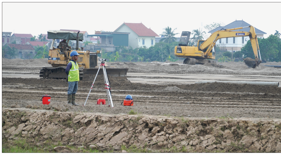
Nhà đầu tư hạ tầng đang đẩy nhanh tiến độ xây dựng hạ tầng kỹ thuật khu công nghiệp Cầu Nghìn, bảo đảm đồng bộ, hiện đại, đáp ứng nhu cầu của các nhà đầu tư thứ cấp.
