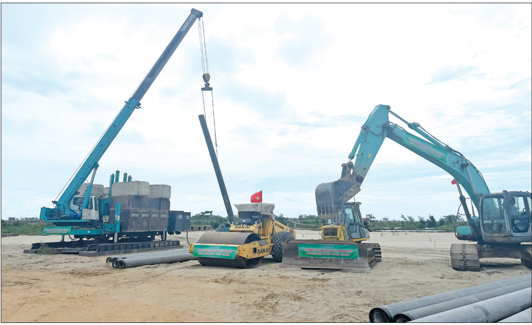
Khởi công xây dựng nhà máy xử lý nước thải khu công nghiệp Hải Long.
