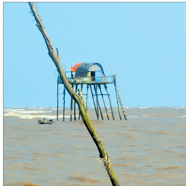
Cắm cọc, dựng lều trái phép tại vùng bãi triều huyện Thái Thụy để trông coi nuôi ngao.
