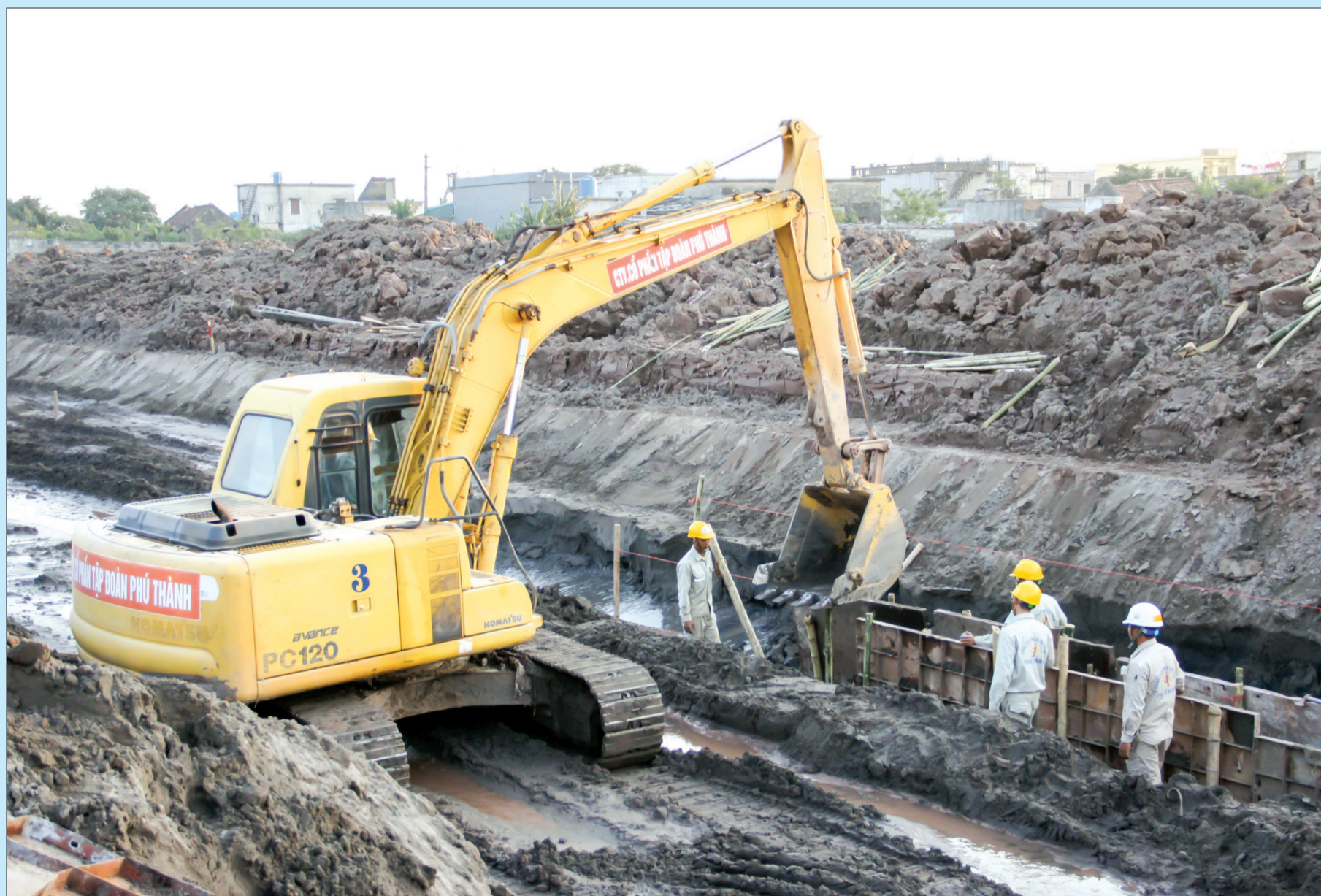
Thi công đường 221A.
