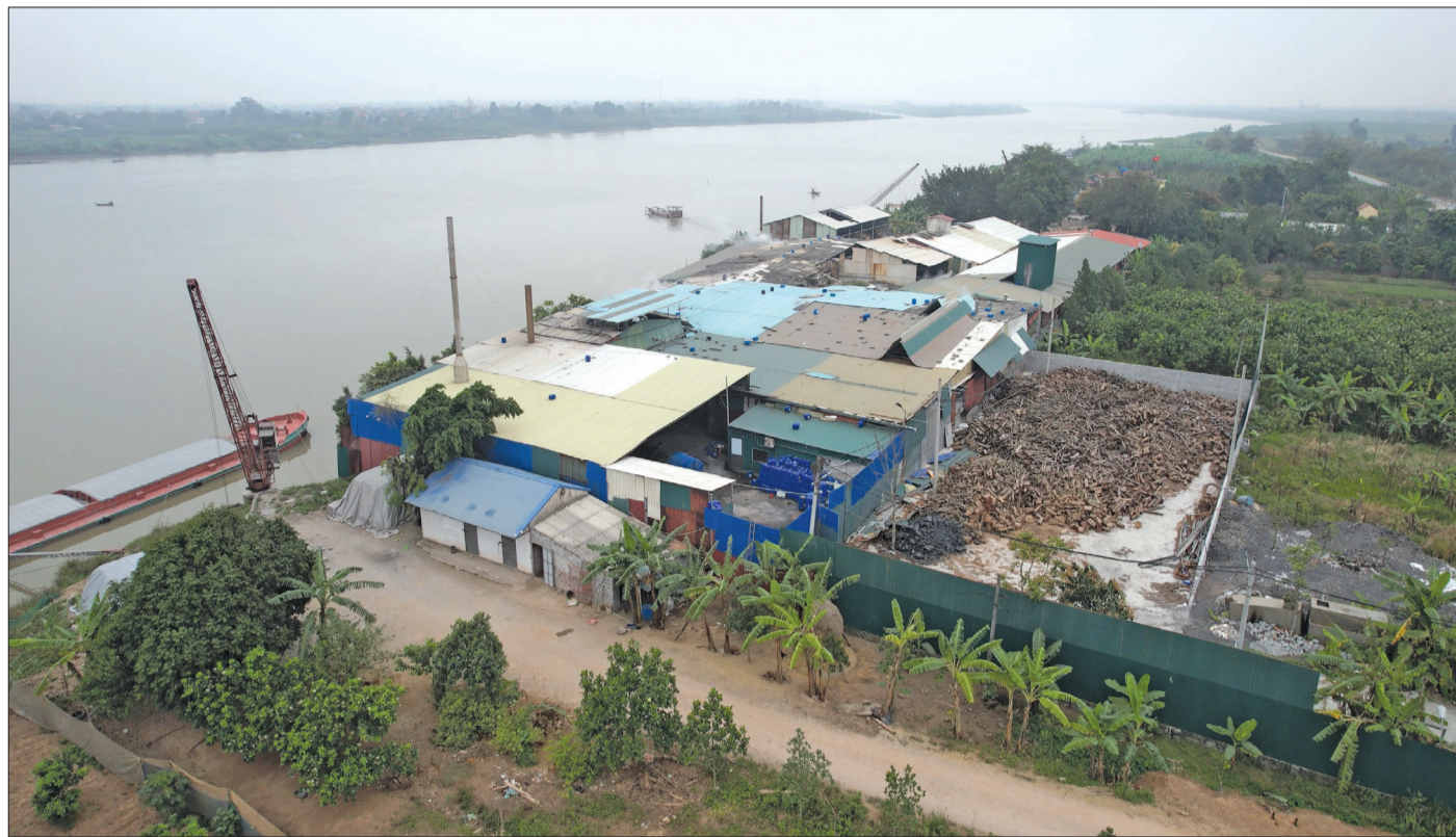
Nhà xưởng xây dựng trái phép trên hành lang đê tại xã Độc Lập (Hưng Hà).
