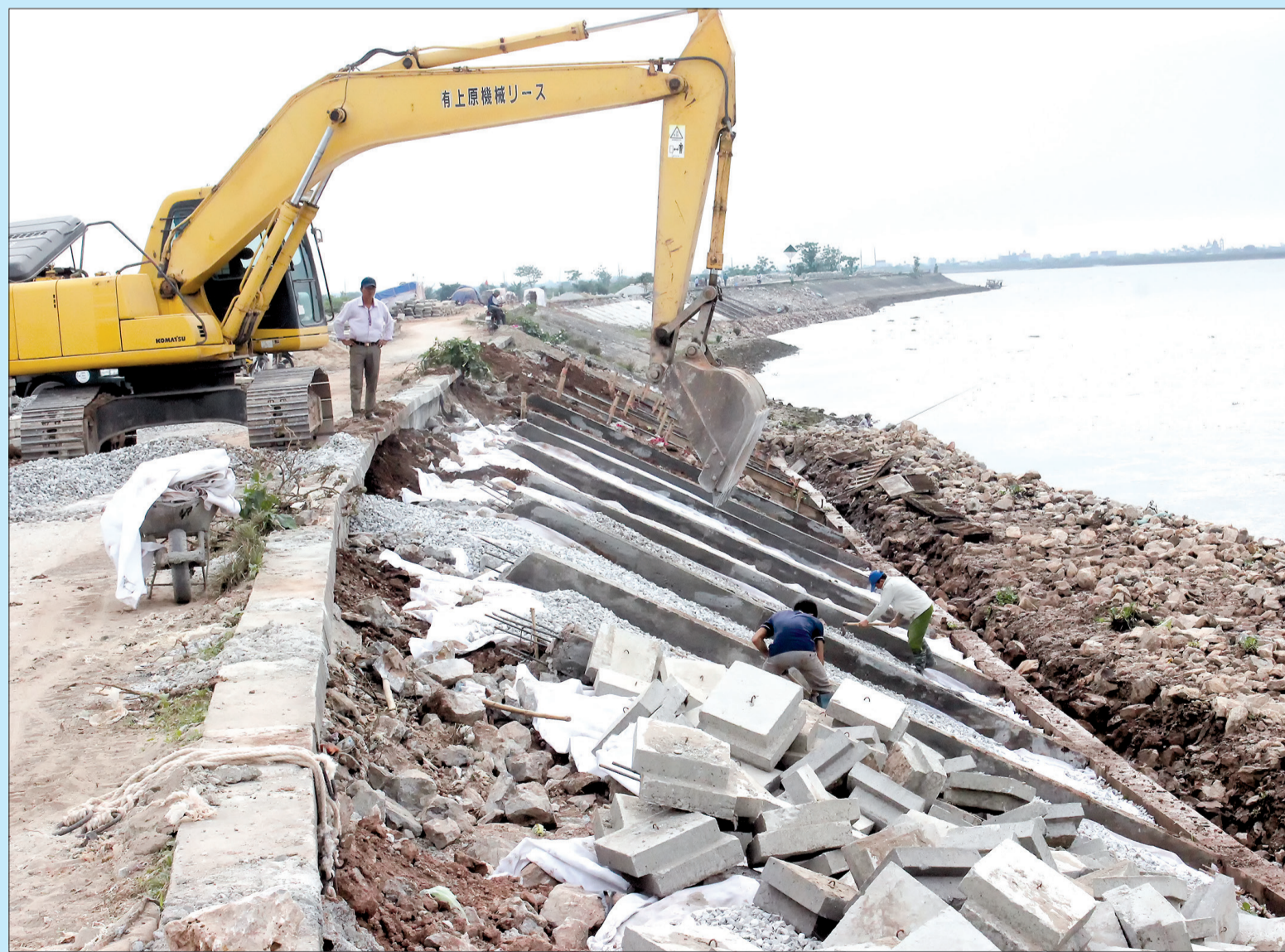
Các nhà thầu huy động máy móc, nhân lực đẩy nhanh tiến độ các công trình phòng, chống lụt, bão tại huyện Tiền Hải.
