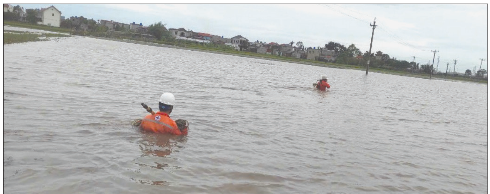
Công nhân Công ty Điện lực Thái Bình dầm mình trong nước vận chuyển vật tư khắc phục sự cố lưới điện.
