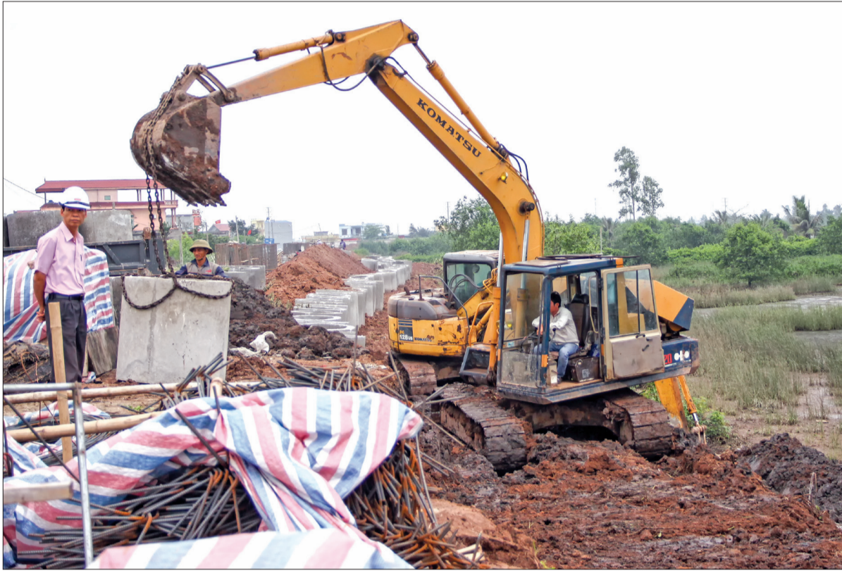
Đơn vị thi công đang đẩy nhanh tiến độ xử lý khẩn cấp đê cửa sông Diêm Hộ, đoạn qua địa phận xã Thụy Liên (Thái Thụy).
