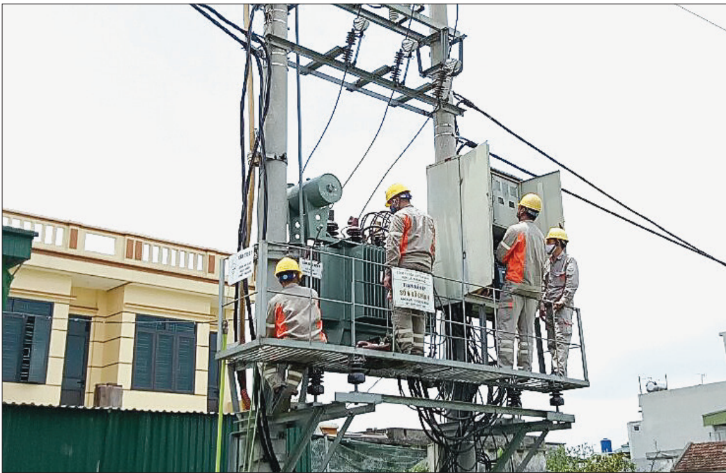
Công nhân Điện lực thành phố Thái Bình kiểm tra hoạt động của máy biến áp.
