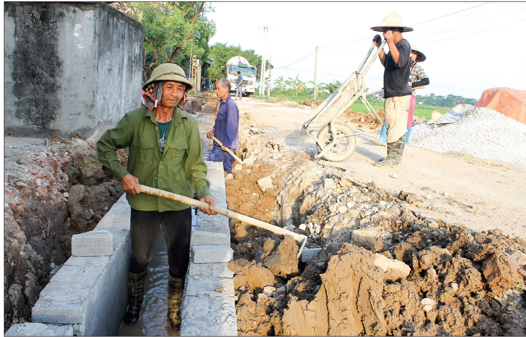
Thi công rãnh thoát nước và cứng hóa mặt đường tuyến đường trục thôn Tường An (xã Tân Hòa, huyện Vũ Thư) theo tiêu chí nông thôn mới nâng cao.
