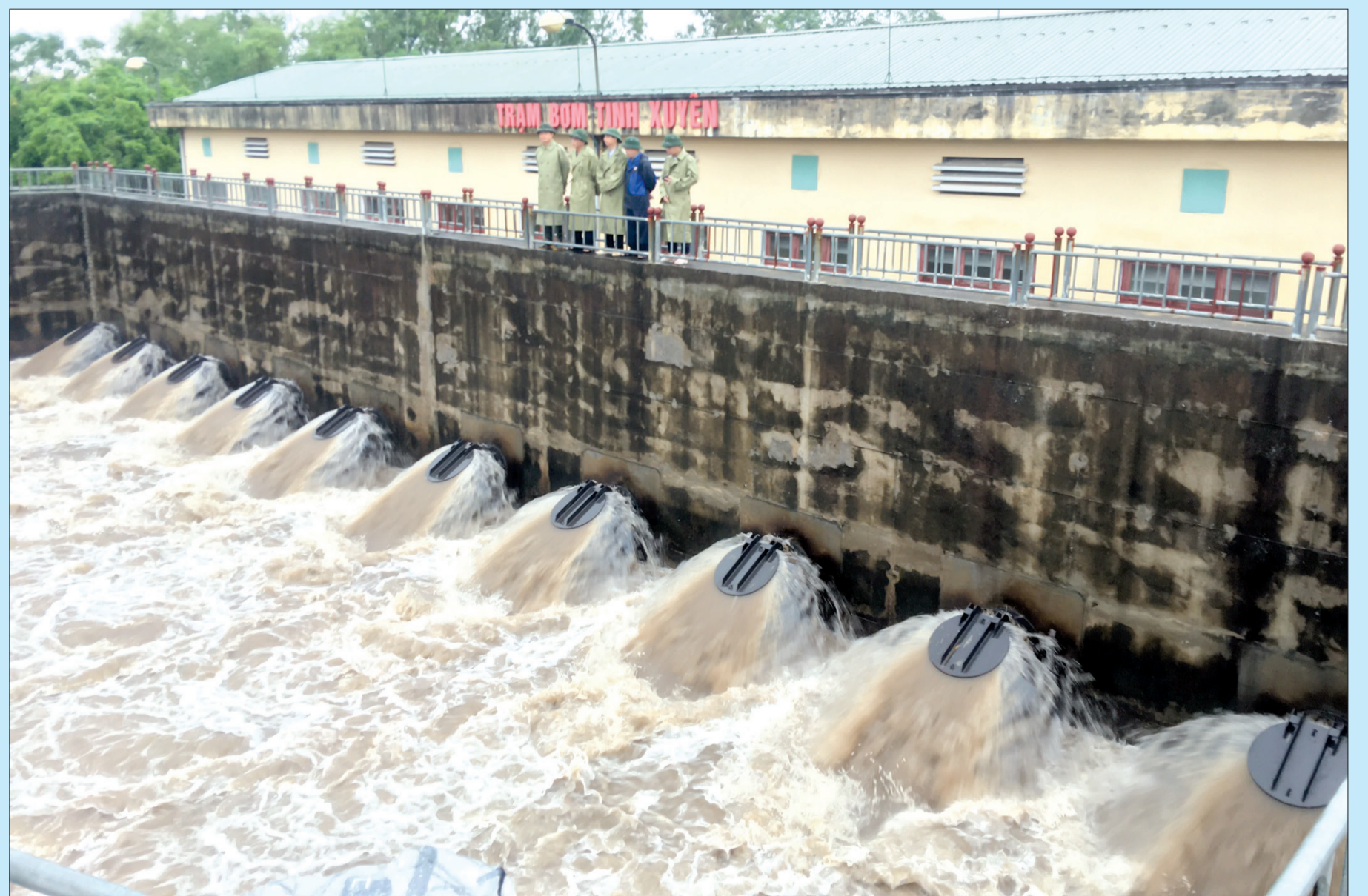
Tiêu úng tại trạm bơm Tĩnh Xuyên (Hưng Hà).
