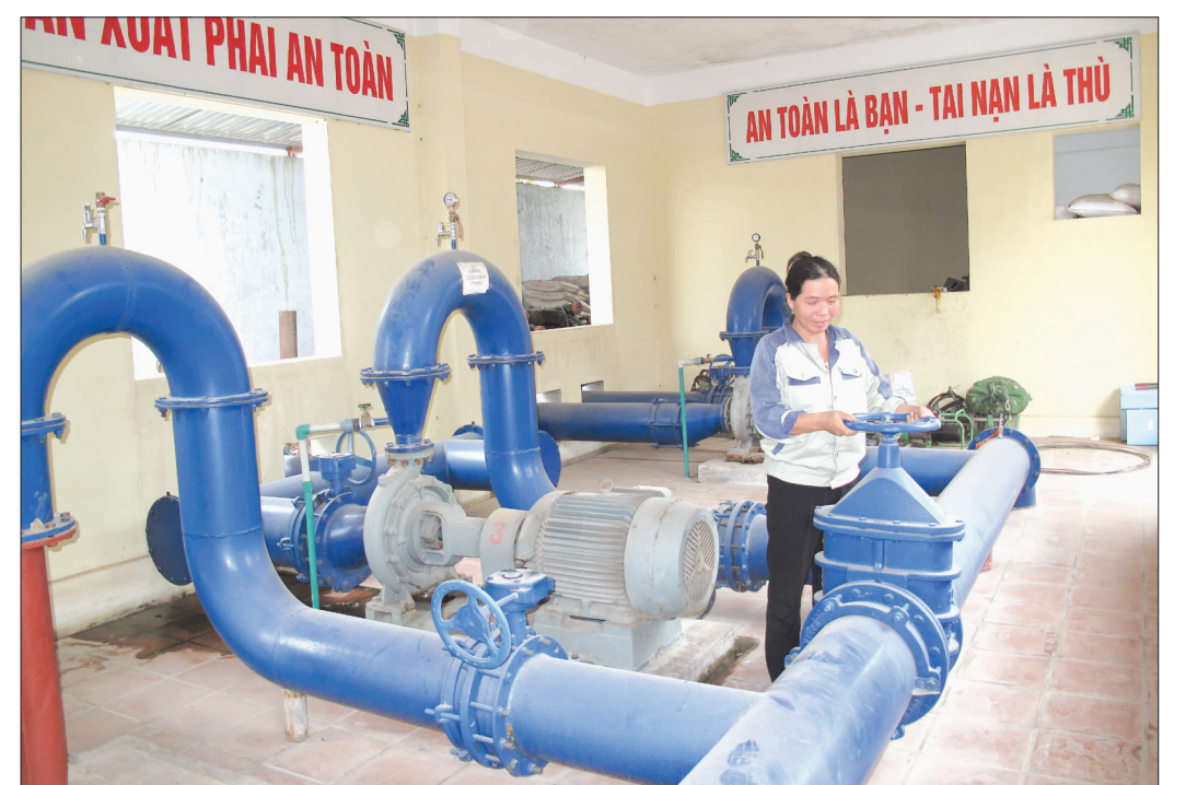
Công nhân nhà máy nước sạch Quỳnh Giao vận hành trạm bơm nước.
