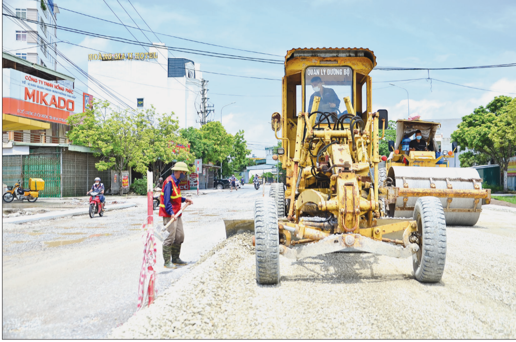
Đơn vị thi công sửa chữa, nâng cấp tuyến đường tỉnh DT.454 đoạn từ cầu Bàng đến ngã tư Bến xe khách Thái Bình.
