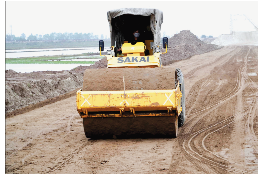
Khu công nghiệp Hải Long được kết nối với tuyến đường bộ ven biển và các huyết mạch giao thông của tỉnh, đường trục trong Khu kinh tế Thái Bình.
