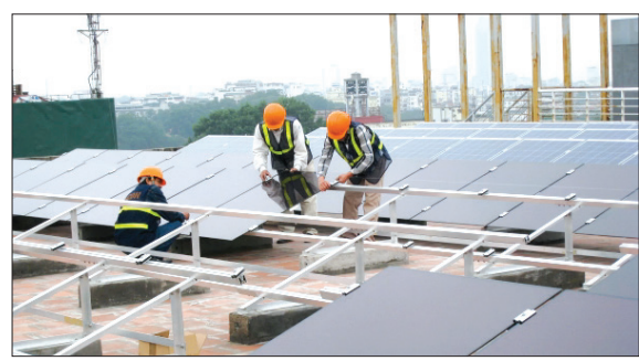
Lắp đặt tấm pin năng lượng mặt trời trên mái nhà cao tầng giúp tiết kiệm điện năng. Ảnh internet
