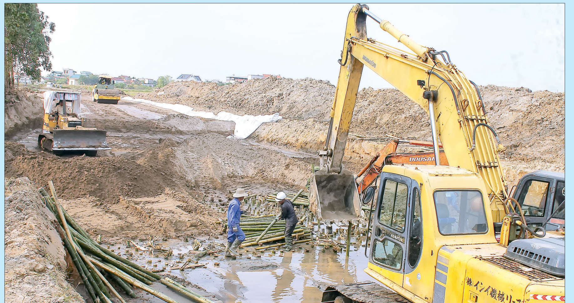
Công tác giải phóng mặt bằng thuận lợi góp phần đẩy nhanh tiến độ thi công dự án đường vành đai phía Nam. Trong ảnh: Thi công dự án đường vành đai phía Nam đoạn qua địa bàn xã Hòa Bình (Vũ Thư).
