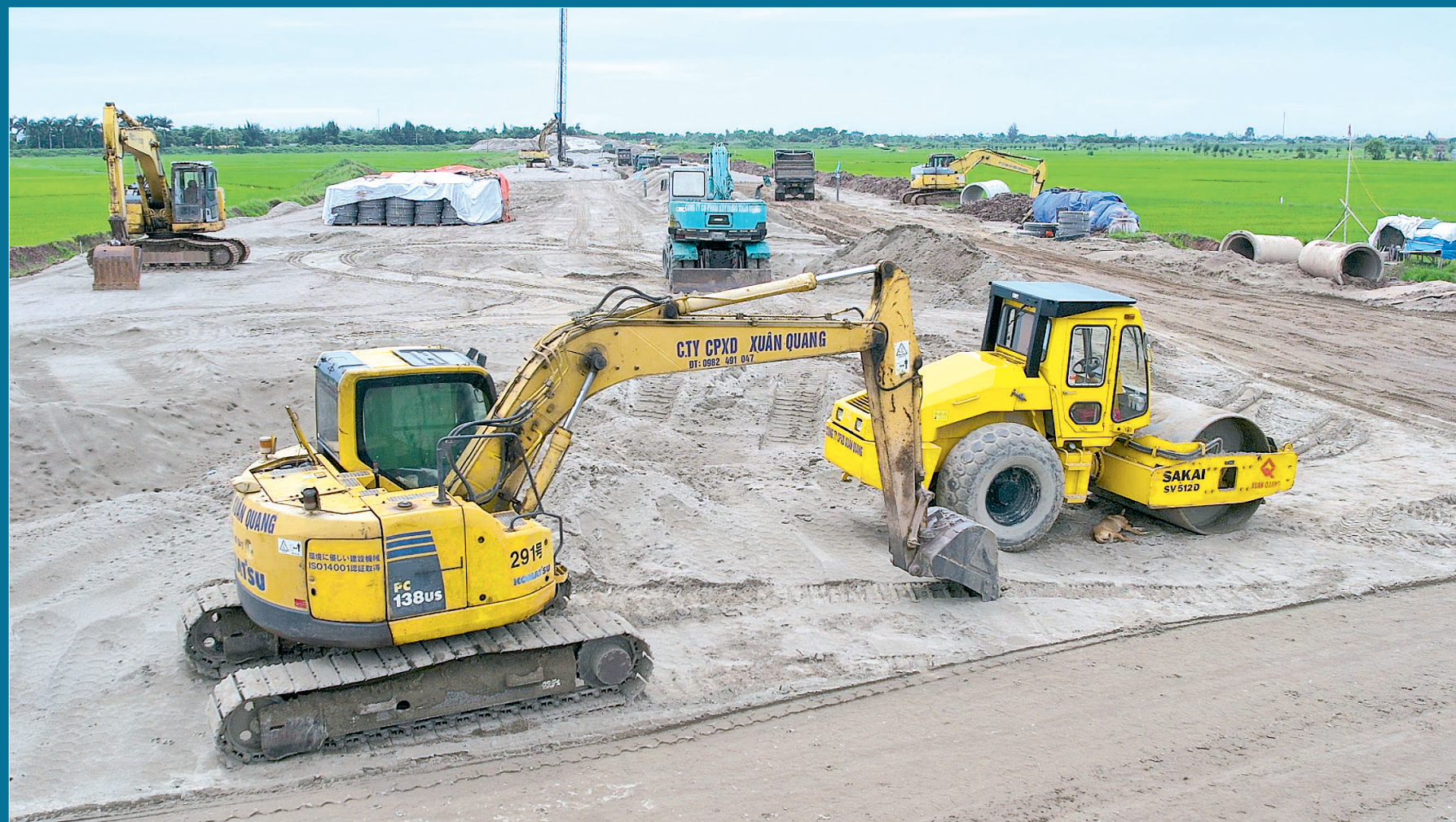
Đơn vị thi công tập trung nhân lực, phương tiện để bảo đảm tiến độ đề ra.
