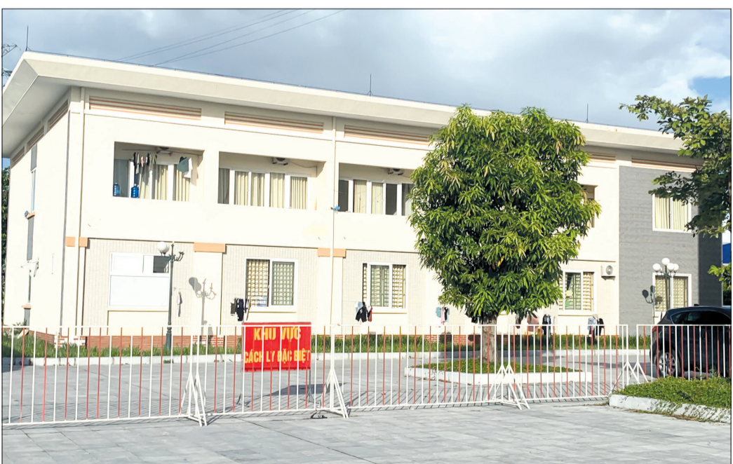
Khu cách ly tập trung đặt tại Trung tâm Chính trị huyện Thái Thụy chuẩn bị đầy đủ cơ sở vật chất để đón công dân từ các địa phương phía Nam về cách ly.
