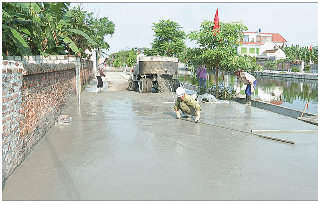
Xã Thụy Chính xây dựng đường giao thông trục thôn theo tiêu chí nông thôn mới nâng cao.
