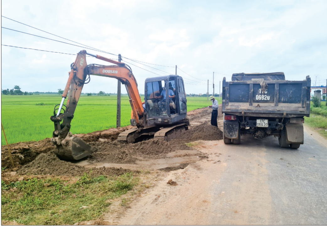
Thi công đường ĐH.48.
