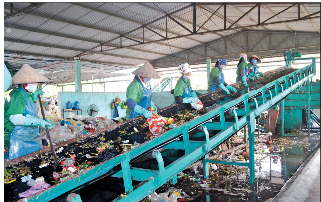
Dây chuyền phân loại rác của nhà máy xử lý rác thải sinh hoạt thị trấn Quỳnh Côi.
