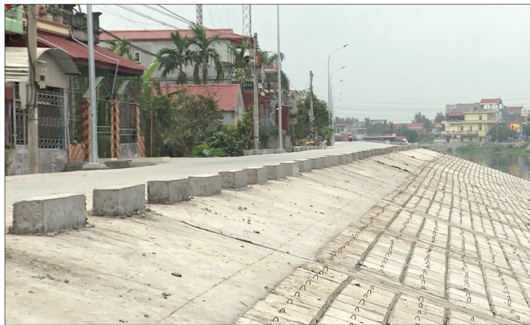
Tuyến kè và đường bờ sông Ngoại Trính, thị trấn Diêm Điền (Thái Thụy) đã hoàn thành.
