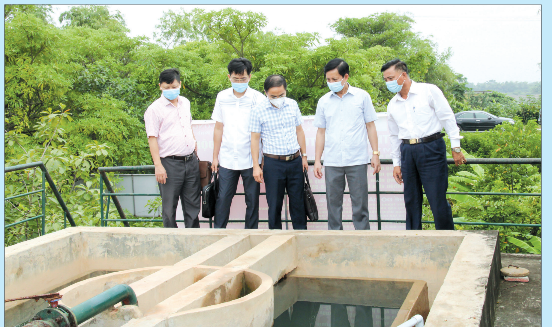
Đoàn kiểm tra liên ngành kiểm tra tại nhà máy cấp nước sạch Minh Tân (Kiến Xương) của Công ty Cổ phần Bitexco Nam Long.
