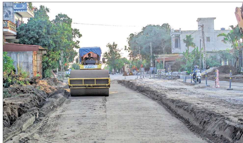
Thi công đường 39B đoạn qua địa phận xã Thái Học (Thái Thụy).
