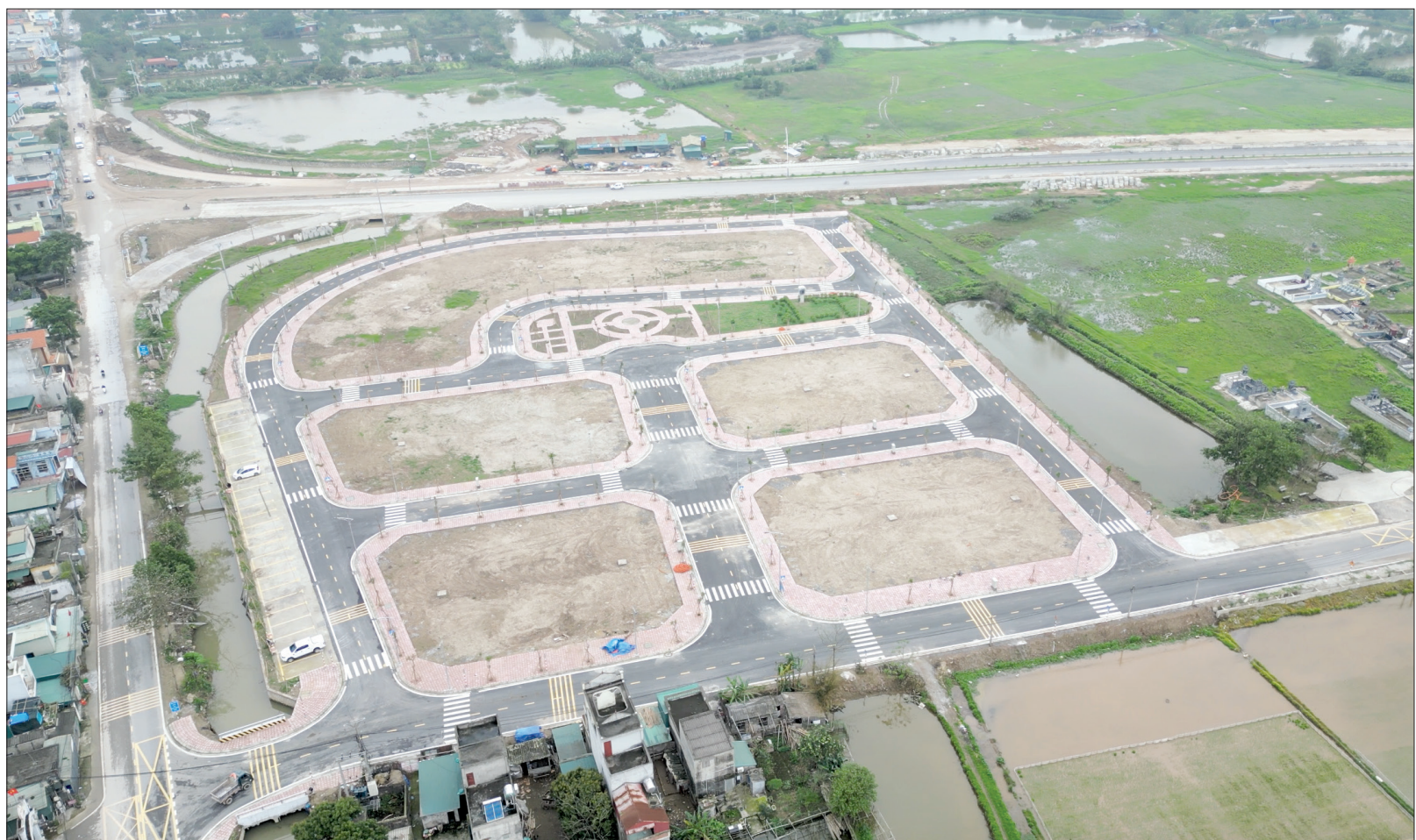
Khu tái định cư tại xã Song An được xây dựng với đầy đủ cơ sở hạ tầng, nằm cách khu vực bị thu hồi đất không xa.
