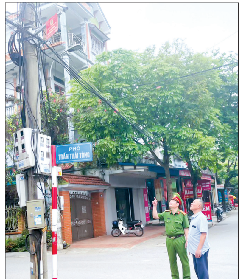
Tại ngã tư tổ dân phố Thị An - Tiên Phong, thị trấn Hưng Nhân được lắp đặt 2 mắt camera giám sát an ninh.
