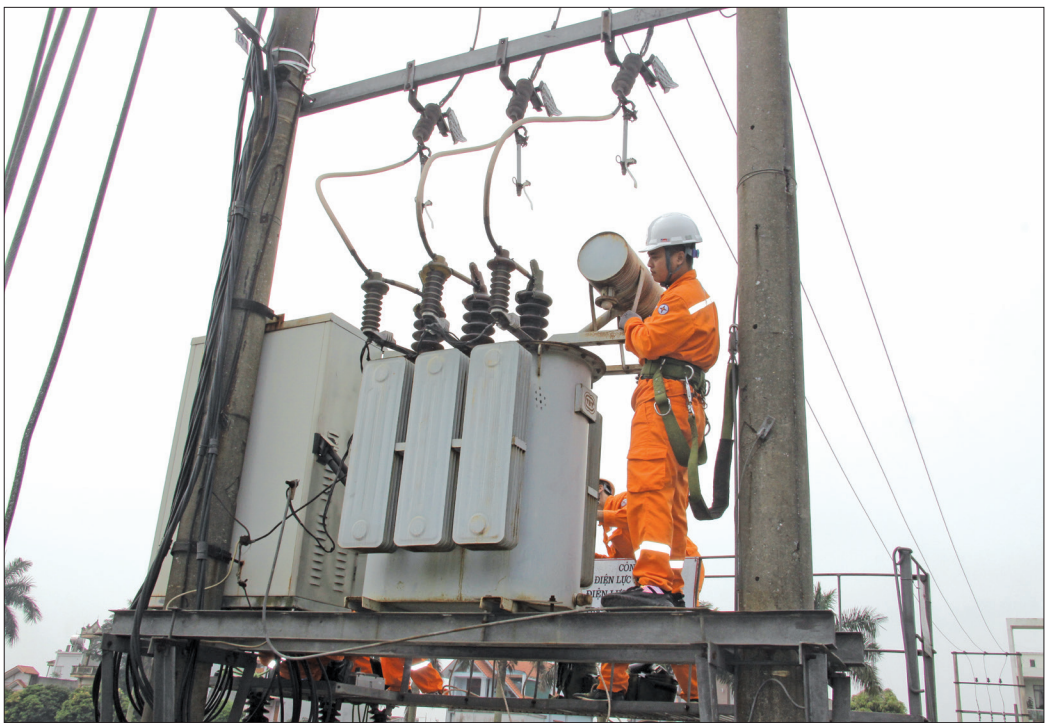
Công ty Điện lực Thái Bình triển khai thay thế máy biến áp bảo đảm cấp điện ổn định, an toàn.
