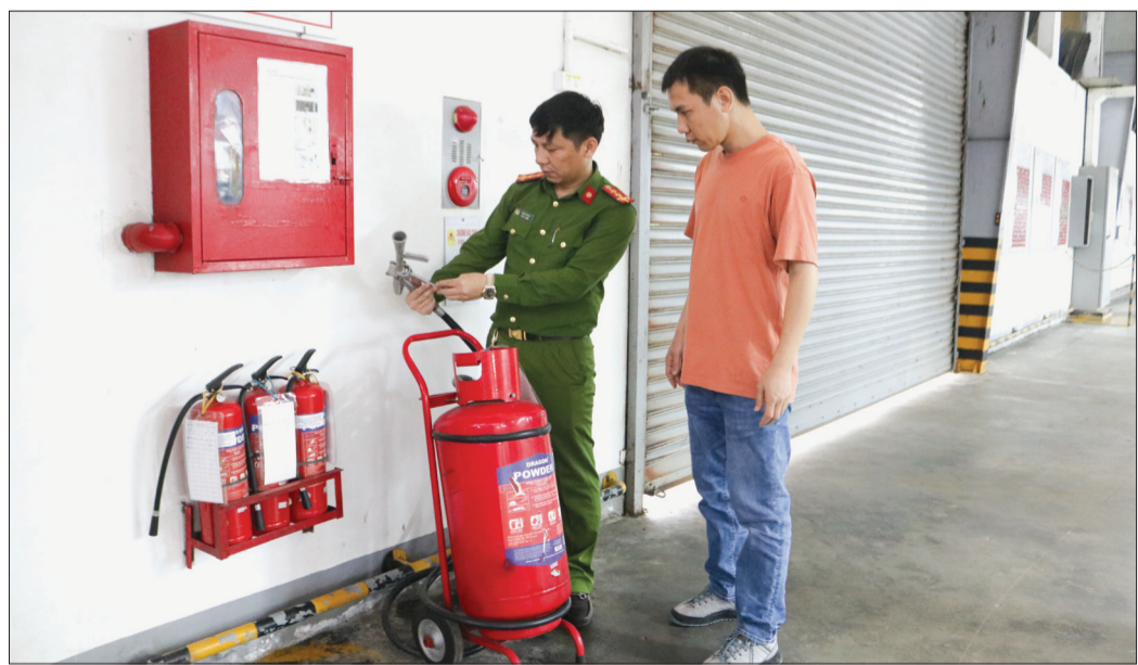
Cán bộ Phòng Cảnh sát phòng cháy, chữa cháy và cứu nạn, cứu hộ, Công an tỉnh kiểm tra an toàn phòng cháy tại Công ty TNHH May Hualida Thái Bình.
