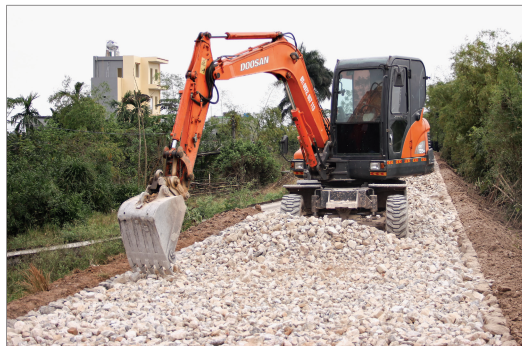
Tu sửa mặt đê đoạn từ k26+200 đến k26+900 đê tả Trà Lý đoạn qua địa phận xã Đông Hòa (thành phố Thái Bình).
