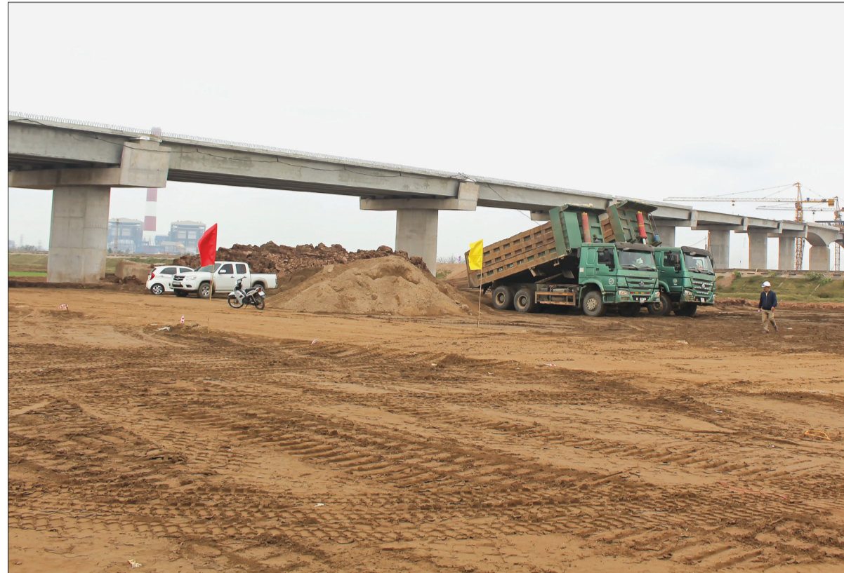
Cầu vượt sông Trà Lý thuộc dự án đầu tư xây dựng tuyến đường bộ ven biển tỉnh Thái Bình sẵn sàng cho lễ hợp long.
