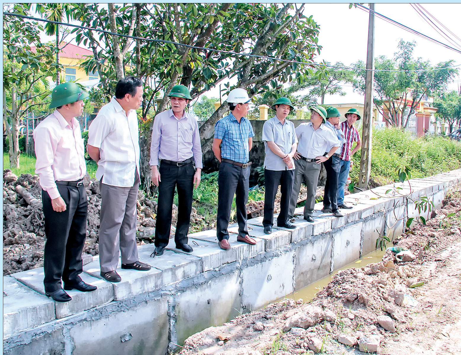
Ban Kinh tế - Ngân sách, HĐND tỉnh giám sát việc quản lý, sử dụng vốn đầu tư xây dựng cơ bản làm đường ĐH.74 qua huyện Quỳnh Phụ.
