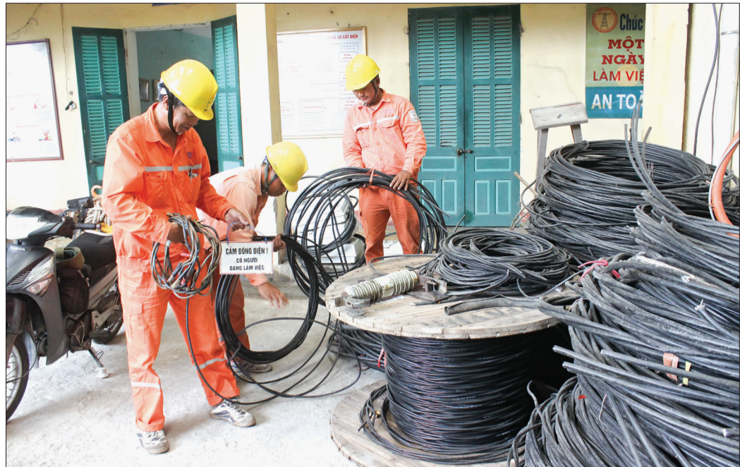
Công nhân Điện lực Đông Hưng chuẩn bị vật tư cài tạo nâng cấp lưới điện hạ áp nông thôn.
