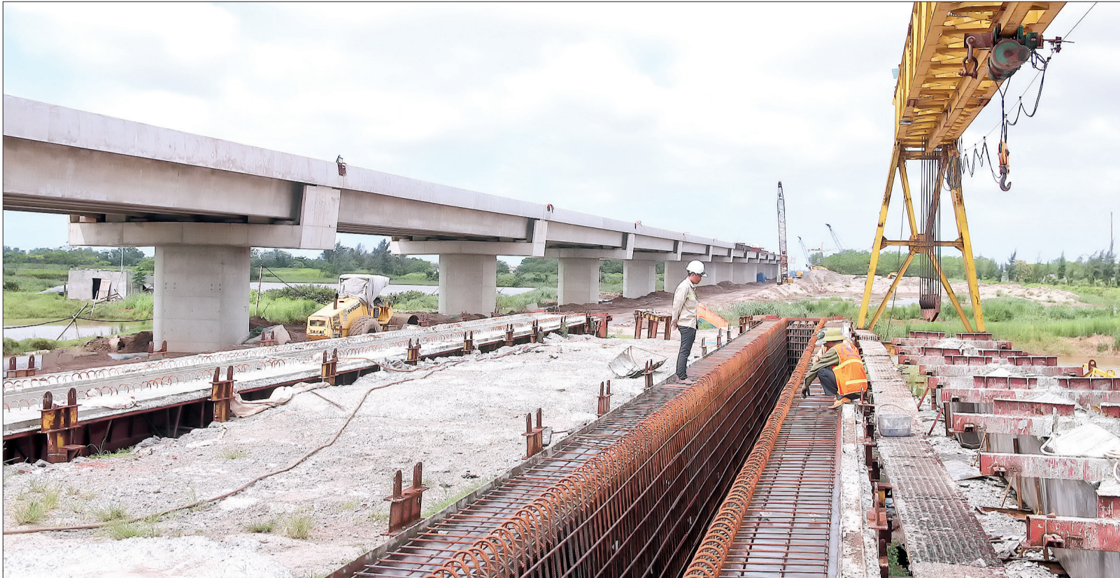
Đến ngày 30/6, dự án đầu tư xây dựng tuyến đường bộ ven biển tỉnh Thái Bình đã giải ngân 100% kế hoạch vốn trung ương phân bổ năm 2022.
