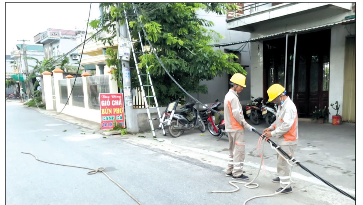
Điện lực Kiến Xương kéo bổ sung dây dẫn chống quá tải bảo đảm cấp điện an toàn, ổn định mùa nắng nóng.
