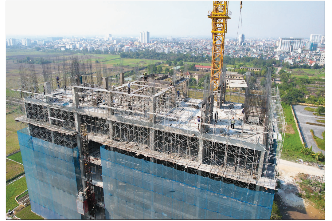
Toàn bộ khu vực thi công tòa nhà Trung tâm Kiểm soát bệnh tật tỉnh đều được quây lưới bảo hiểm xung quanh.
