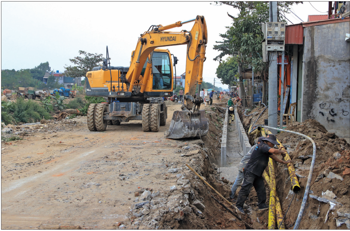
Thi công rãnh dọc thoát nước tại dự án cải tạo, nâng cấp đường tỉnh ĐT.452 (đường 224) đoạn từ đường Thái Bình - Hà Nam đến xã Dân Chủ.
