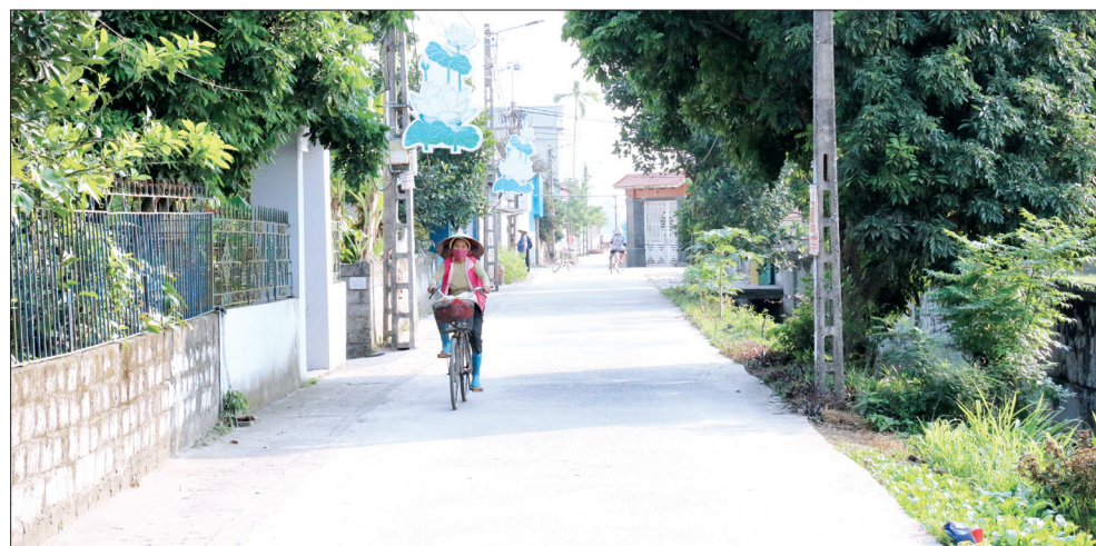
Hệ thống đường giao thông xã Quỳnh Bảo (Quỳnh Phụ) được đầu tư xây dựng và lắp đặt hệ thống điện chiếu sáng.
