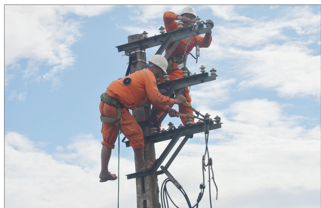
Công nhân Điện lực Quỳnh Phụ "căng mình" chống chịu với nắng nóng để cấp điện ổn định cho người dân.
