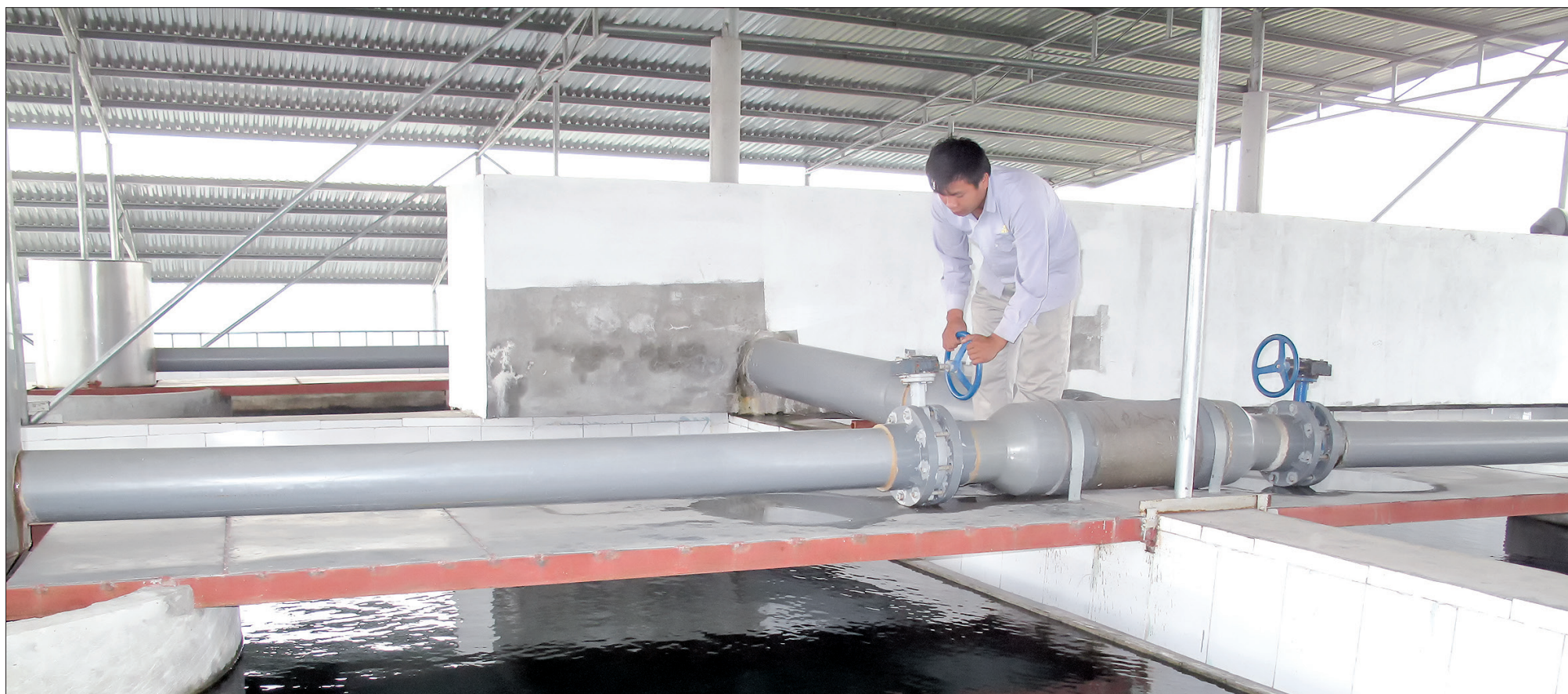
Nhà máy nước sạch Thái Dương hoạt động ổn định cung cấp nước sạch cho người dân.
