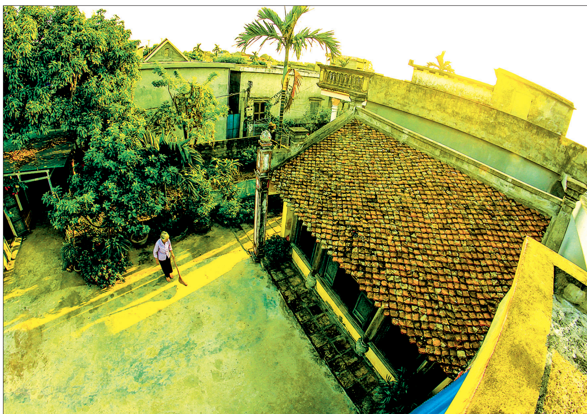
Từ đường tiến sĩ Nguyễn Viêm ở thôn Lam Cầu 1 nhỏ bé đơn sơ như chính cuộc đời thanh liêm chính trực của ông. Hiện từ đường đang xuống cấp nghiêm trọng.
